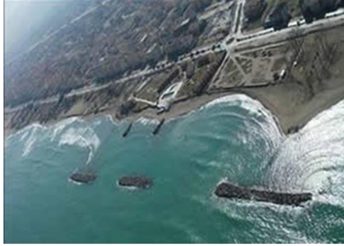
Şekil 33. Karasu (Solda) ve Konyaaltı (Sağda) Plajlarına Gözlemlenen Kıyı Erozyonu (Kutoğlu vd., 2011)
