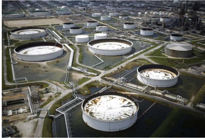
Şekil 3. Hasarlı Rafinerilerin Görünüşü
