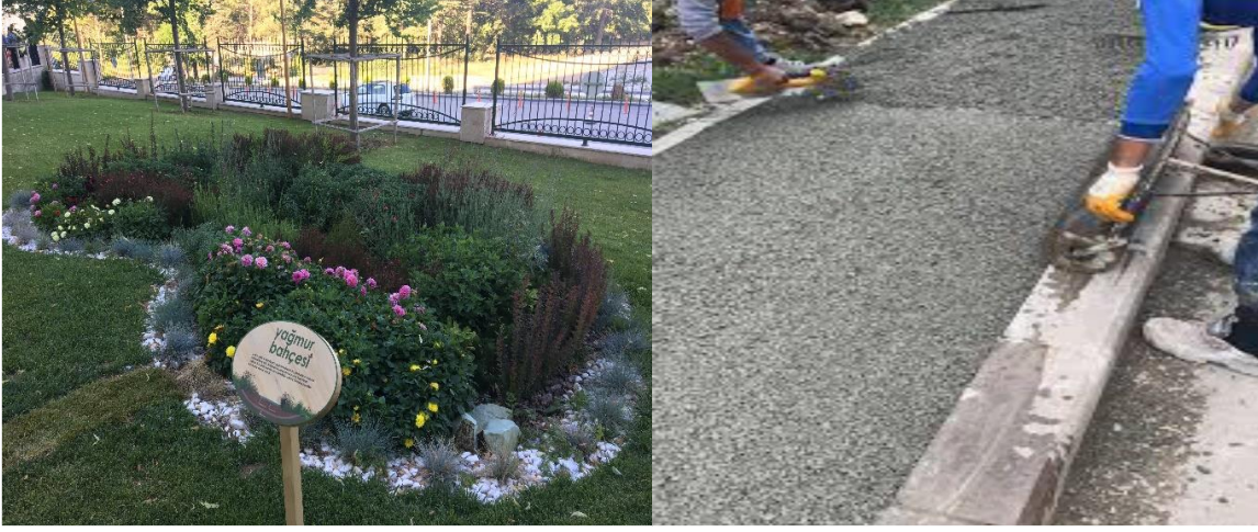
Şekil 12. Yağmur Bahçesi ve Geçirimli Beton Uygulaması
