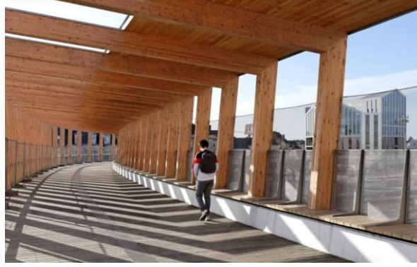
Şekil 13-51. Yaya Köprüsünde Farklı İklim Koşullarından Koruyucu Bariyer
