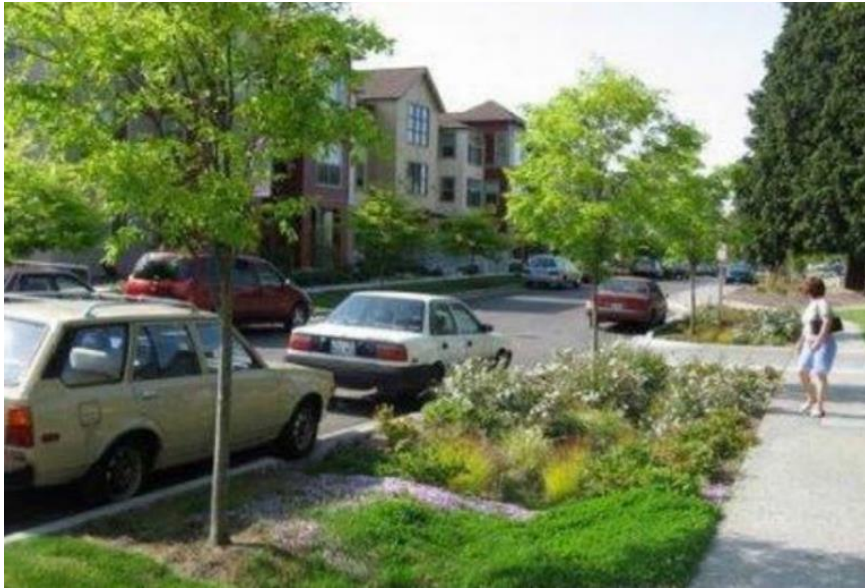
Şekil 13-40 Gölge ve Geçirgen Yüzey Etkisini Arttıran Peyzaj Müdahaleleri
