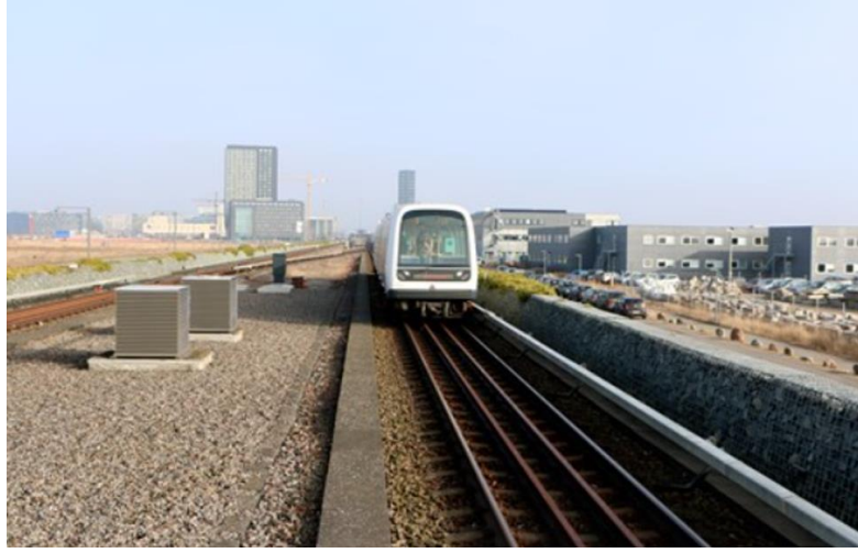
Şekil 13-35 Demiryolu İçin Koruyucu Siper Örneği
