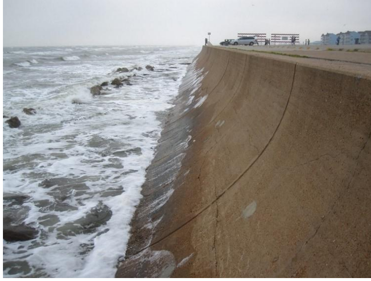
Şekil 13-33 Deniz Kıyısındaki Yollara Özg Koruyucu Bariyer Örneđi (Coastal Protection Structures, 2022)
