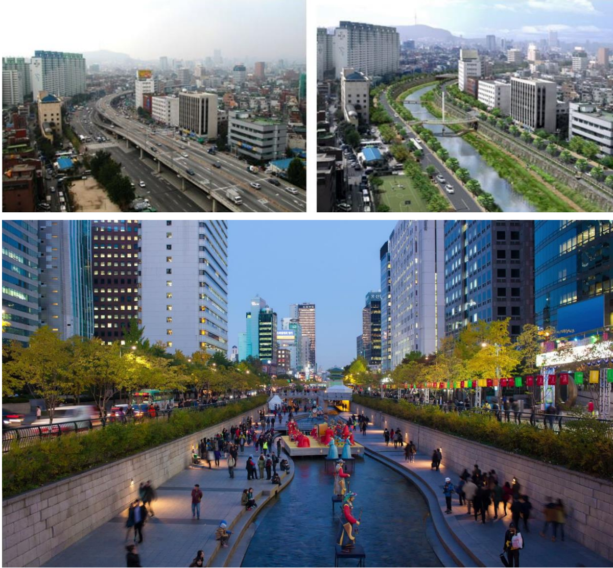
Şekil 13-41 Seul Örneđi, Üstü kapatılan akarsu yatađının yeniden kente kazandırılması; bu süreçte taşıt yolu en kesitinin yeniden tasarlanması; yaya ve taşıt dengesinin yanı sıra kentte yeşil ve mavi altyapıların artırılması
